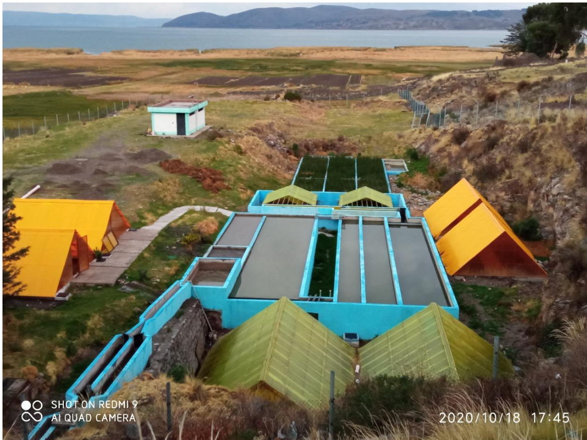
Vista general de la PTAR Norte del Distrito de Chucuito, Puno.
